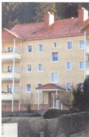
Die Mehrfamilienhäuser mit der sanierten Fassade auf Basis des Zierer-Systems. Fotos: Zierer
