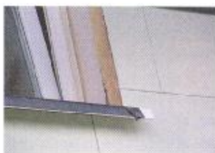
Der Schichtenaufbau des Zierer-Fassadensystems.
