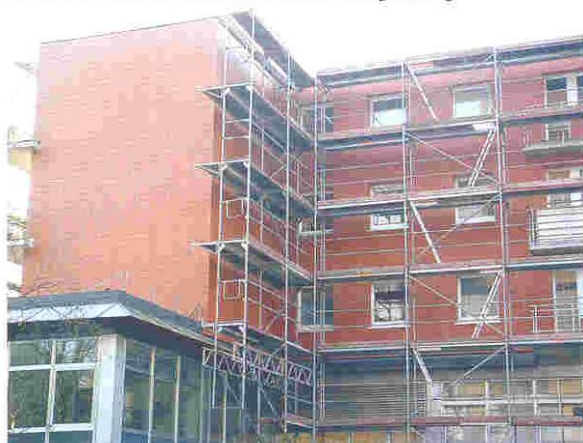
Wohn- und Geschäftshaus kurz vor der Fertigstellung
